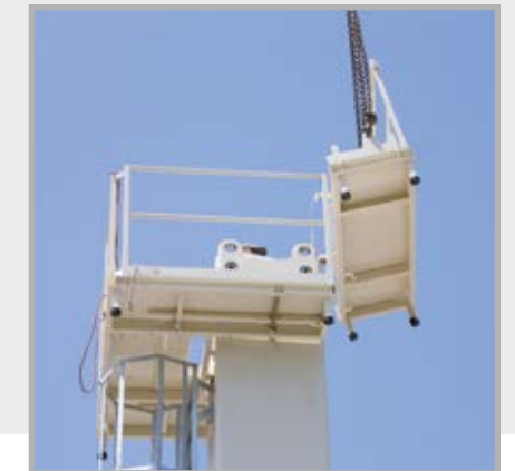
Aufbau eines MX-Mastes mit der optionalen Sicherheitsarbeitsbühne
