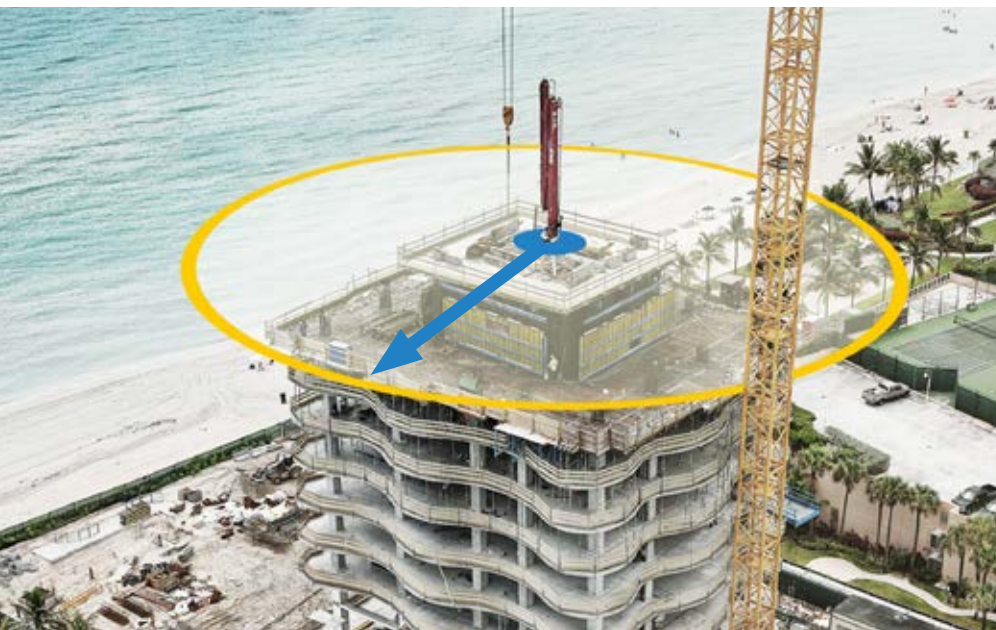
Bildquelle: Doka GmbH, Amstetten
